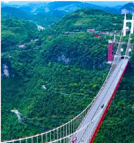
• 穿梭云端的「矮寨大桥」 Aizhai Bridge
