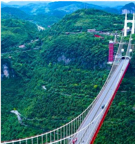
• 穿梭云端的「矮寨大桥」 Aizhai Bridge
